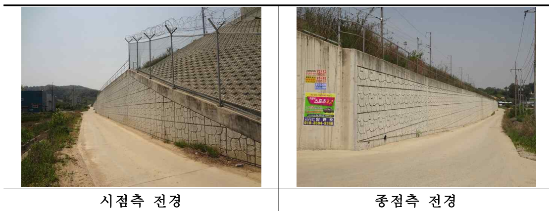
<그림 4.1.2> 역T형 옹벽 현황
